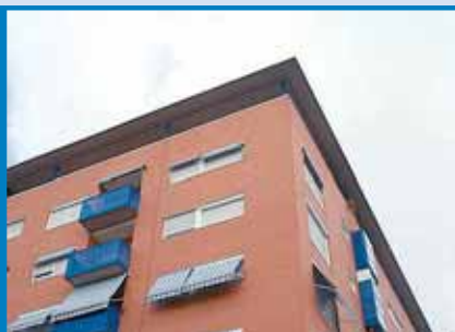
La construcción de pisos sigue a ritmo frenético.
